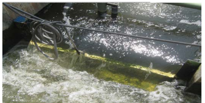
Aerazione disinfezione – Scarico finale
